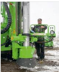
Konzentriert steuert Peter Reckziegel den Bohrram der Big Mama nach unten, bis dessen Gummimanschette auf dem Boden aufsitzt.
